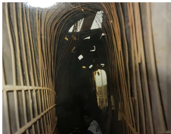
Figura 11. Obras em andamento.
