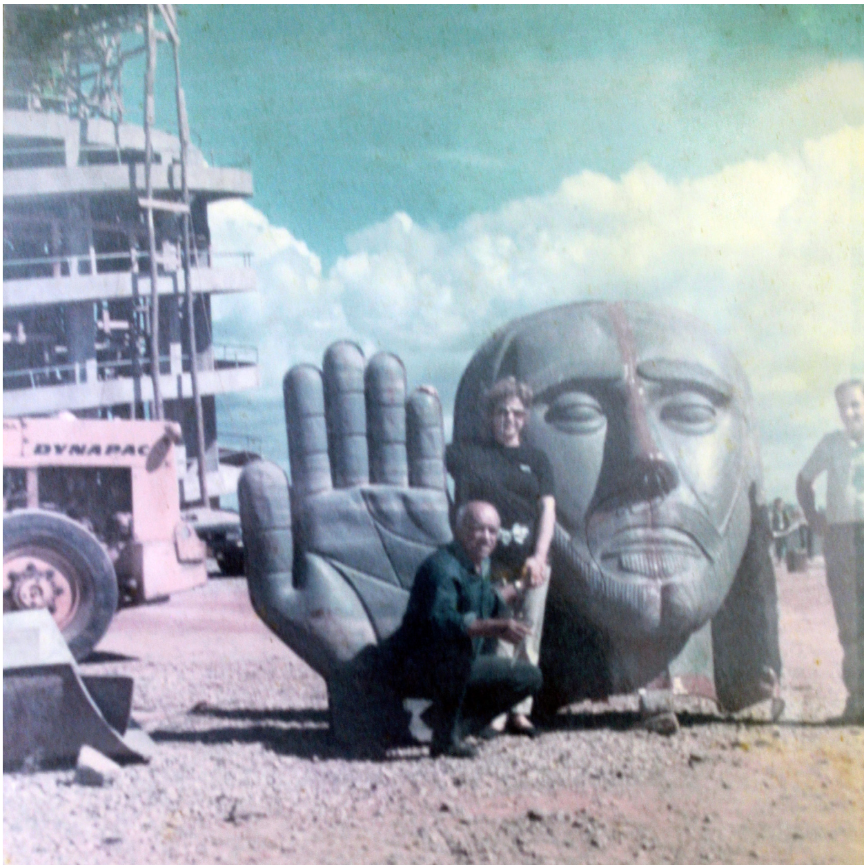
Figura 4. Forma de madeira que serviu como molde para confecção do Cristo. Na foto, à direita, Sr. Vicente Martins Alves. Fonte: Acervo de Mauro Dutra de Faria. Foto cedida pela Secretaria Municipal de Cultura de Conselheiro Lafaiete (sem data).
