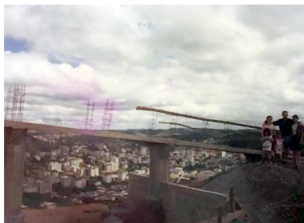
Figura 10. Obras em andamento. Em destaque, rampa que dá acesso à estátua.
